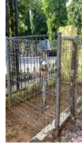
Kondisi pos ( baik) Kondisi pagar (baik) Kondisi gembok dan papan nama (tidak ada)
