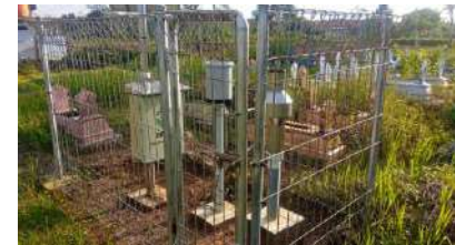
Kondisi pos (baik) Kondisi pagar dan gembok (baik) Kondisi papan nama (tidak ada)
