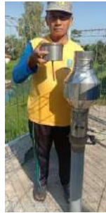
Kondisi corong (baik)
