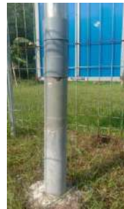
Kondisi tiang penyangga (baik)
