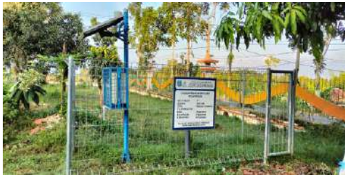
Kondisi papan nama (baik) Kondisi pagar (baik) Kondisi gembok (tidak)
