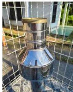
Kondisi corong (baik)
