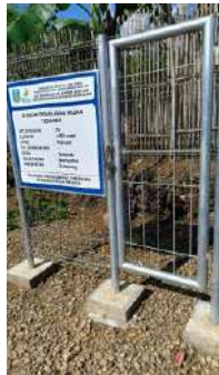
Kondisi papan nama (baik) Kondisi pagar dan gembok (baik)
