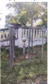
Kondisi pagar dan gembok (baik)
