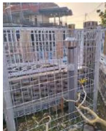
Kondisi tiang penyangga (baik) Kondisi alat (tegak)
