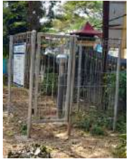
Kondisi pagar dan gembok (baik)
