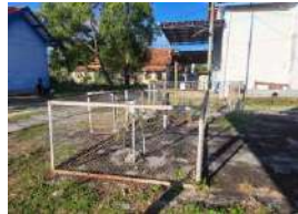
Kondisi pagar (baik) Kondisi papan nama dan gembok (tidak ada)
