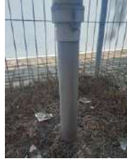
Kondisi tiang penyangga (baik)
