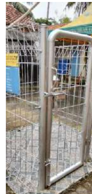
Kondisi pagar (baik) Kondisi gembok (tidak ada)
