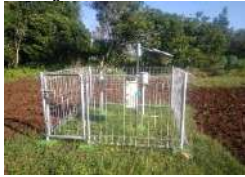
Kondisi pagar dan gembok (baik) Kondisi papan nama (tidak ada)
