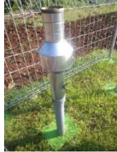
Kondisi corong (baik)
