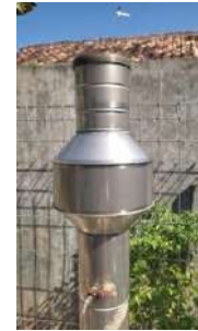
Kondisi corong (baik)
