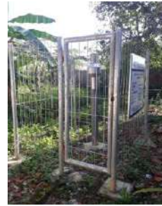
Kondisi pagar (baik) Kondisi gembok (tidak ada)
