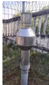
Kondisi keran berkarat (sedang) Kondisi corong (baik)
