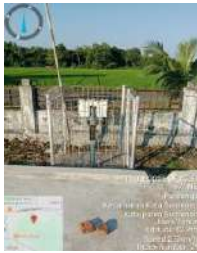
Kondisi pos (baik)
