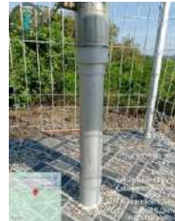
Kondisi tiang penyangga (baik) Kondisi alat (tegak)
