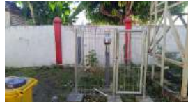
Kondisi pagar dan gembok (baik)
