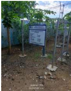
Kondisi pagar (baik) Kondisi papan nama (baik) Kondisi gembok (baik)
