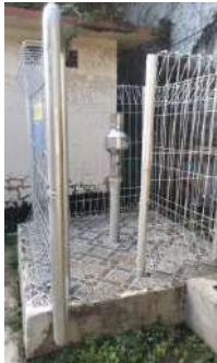
Kondisi pagar (baik) Kondisi gembok (tidak ada)
