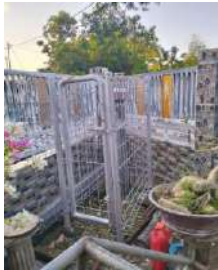
Kondisi pagar (baik) Kondisi papan nama dan gembok (tidak ada)
