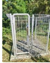
Kondisi pagar (baik) Kondisi gembok (tidak ada)
