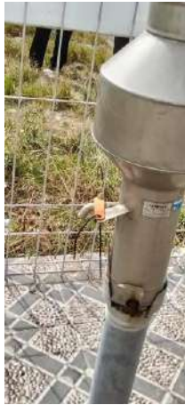
Kondisi kran (baik)
