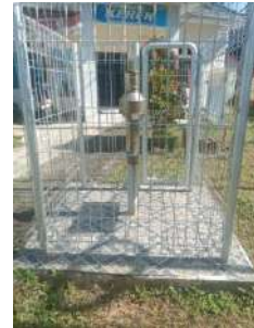
Kondisi ombrometer (baik)
