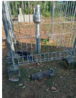
Kondisi pos (baik) Kondisi pagar (baik) Kondisi papan nama dan gembok (tidak ada)
