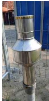
Kondisi corong baik
