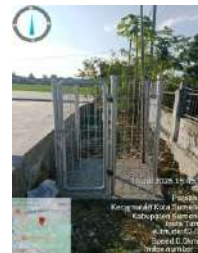
Kondisi pagar (baik) Kondisi gembok (baik)
