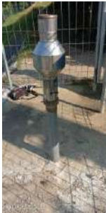
Kondisi ombrometer (tegak)
