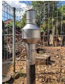
Kondisi tiang penyangga (baik) Kondisi keran berkarat (sedang)
