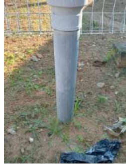
Kondisi tiang penyangga (baik)
