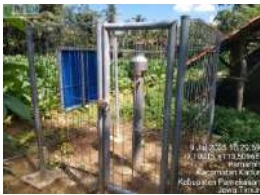
Kondisi pagar dan gembok (baik)
