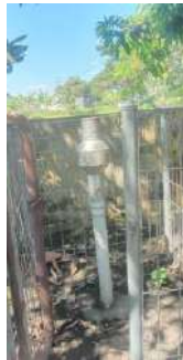
Kondisi pagar (baik) Kondisi gembok dan papan nama (tidak ada)
