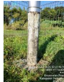
Kondisi tiang penyangga (baik)
