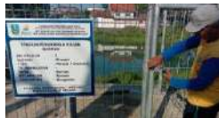
Kondisi pagar dan gembok (baik)
