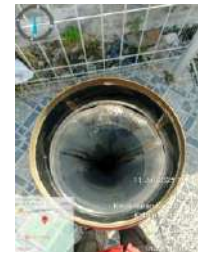
Kondisi corong (baik)
