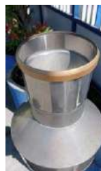
Kondisi corong (baik)
