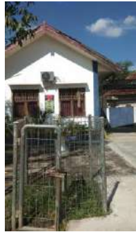
Kondisi papan nama dan gembok (tidak ada) Kondisi pagar (baik)
