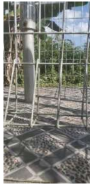
Kondisi pagar (baik) Kondisi gembok (tidak ada)
