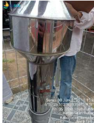
Kondisi keran (rusak)
