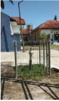
Kondisi alat miring (sedang)
