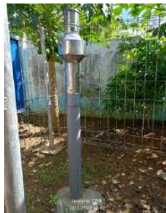
Kondisi tiang penyangga (baik) Kondisi alat (tegak)
