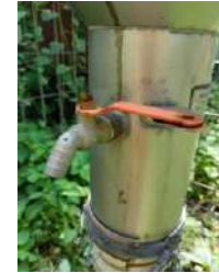
Kondisi tiang penyangga (baik)
