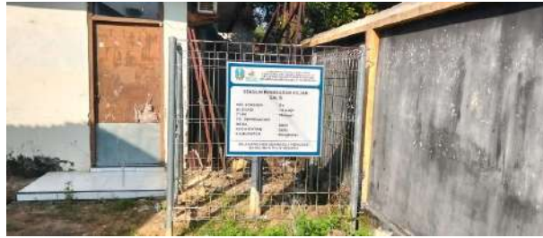
Kondisi gembok (tidak) Kondisi papan nama (baik) Kondisi pagar (baik)
