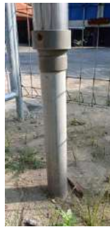
Kondisi tiang penyangga (baik)
