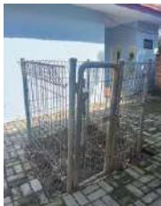
Kondisi pagar dan gembok (baik) Kondisi papan nama (tidak ada )
