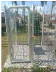
Kondisi pagar Kondisi keran berkarat (sedang)
