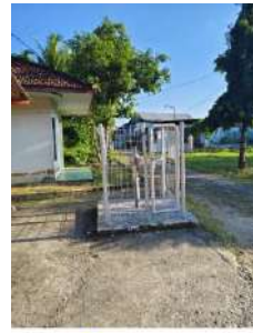
Kondisi pagar (baik) Kondisi gembok (tidak ada)
