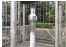
Kondisi keran dan corong (baik) Kondisi tiang penyangga (baik)
