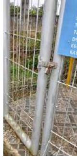
Kondisi pagar dan gembok (baik)
