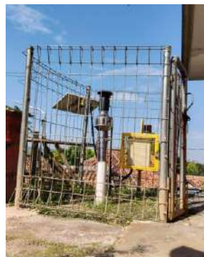
Kondisi pos (baik) Kondisi papan nama (tidak ada) Kondisi pagar(baik) Kondisi gembok (tidak ada)
