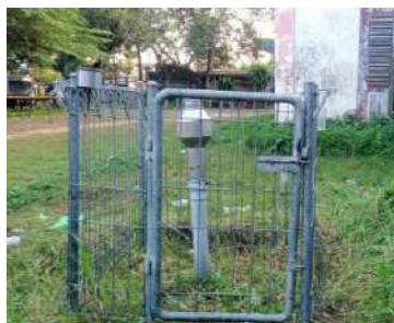
Kondisi pagar (baik) Kondisi gembok (tidak ada)
