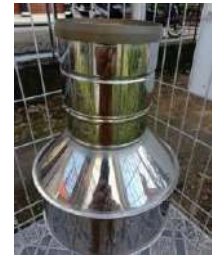
Kondisi corong (baik)
