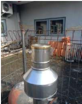
Kondisi corong (baik)
