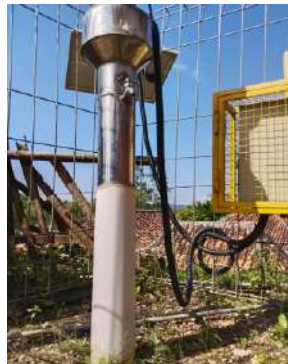
Kondisi tiang penyangga (baik)
