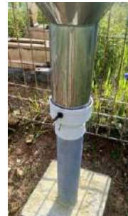
Kondisi tiang penyangga (baik)
