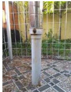
Kondisi tiang penyangga (baik)
