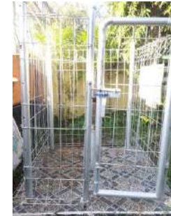
Kondisi pagar (baik) Kondisi gembok (tidak ada)
