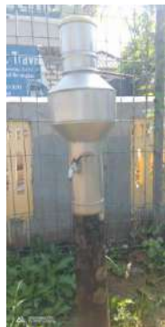
Kondisi tiang penyangga (baik)
