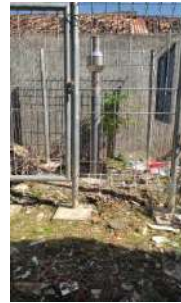
Kondisi pagar dan gembok (baik)
