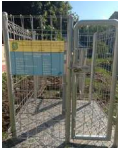
Kondisi papan nama (baik) Kondisi gembok dan pagar (baik)
