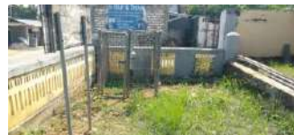
Kondisi pos (baik) Kondisi papan nama (tidak ada)
