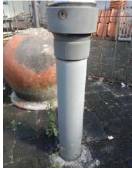
Kondisi pondasi (baik)
