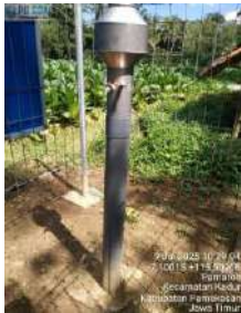
Kondisi tiang penyangga (baik)
