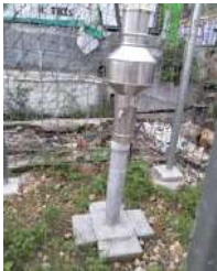
Kondisi alat miring (sedang)
