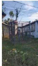
Kondisi pos (baik) Kondisi papan nama (tidak ada)
