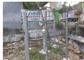
Kondisi pos (baik) Kondisi pagar (baik) Kondisi papan nama dan gembok (tidak ada)
