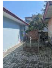
Kondisi pos (baik)
