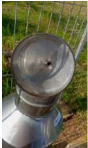
Kondisi corong (baik)
