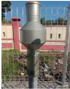
Kondisi corong (baik)
