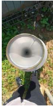
Kondisi corong (baik)
