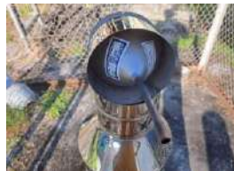
Kondisi corong (baik)
