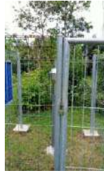
Kondisi pagar (baik) Kondisi gembok (baik)
