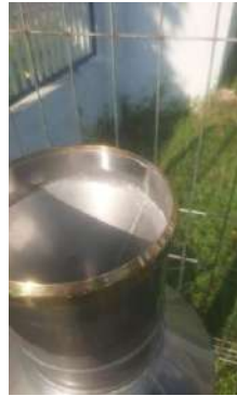
Kondisi corong (baik)
