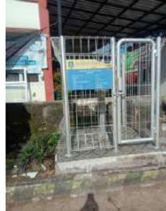
Kondisi papan nama dan pos (baik) Kondisi pagar (baik) Kondisi gembok (tidak ada)
