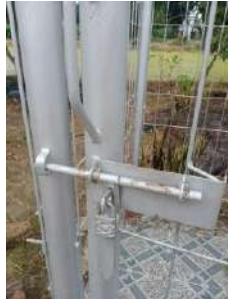
Kondisi pagar dan gembok (baik)
