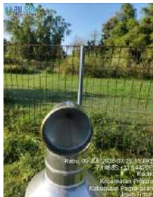
Kondisi corong (baik)
