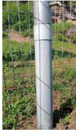
Kondisi tiang penyangga (baik)
