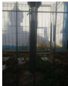
Kondisi tiang penyangga (baik)
