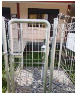
Kondisi pagar (baik) Kondisi gembok (tidak ada)
