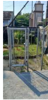
Kondisi pagar dan gembok (baik)
