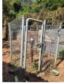
Kondisi pagar (baik) Kondisi gembok (tidak ada)
