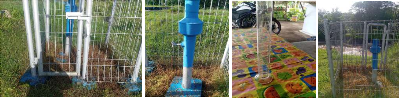
Keterangan : Gambar Kondisi Pos
