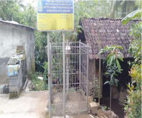
Keterangan : Gambar Kondisi Pos
