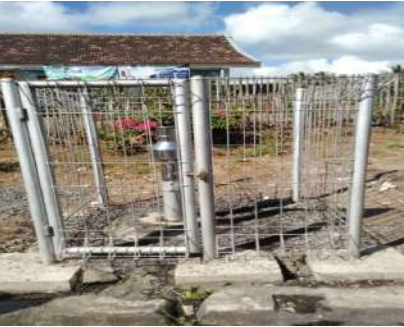
Keterangan : Gambar Kondisi Pos
