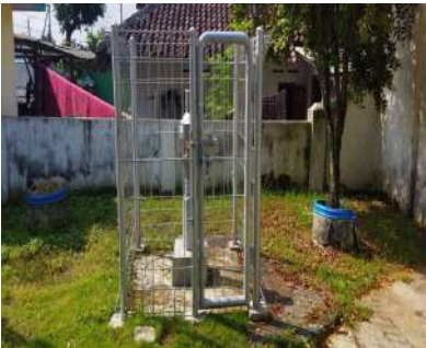
Keterangan : Gambar Kondisi Pos
